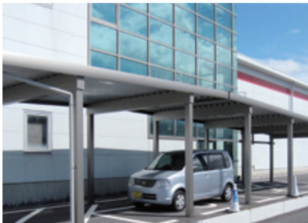
障害者用カーポートの設置
