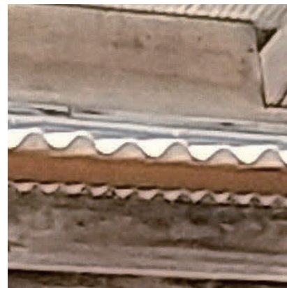
工法①改修後
