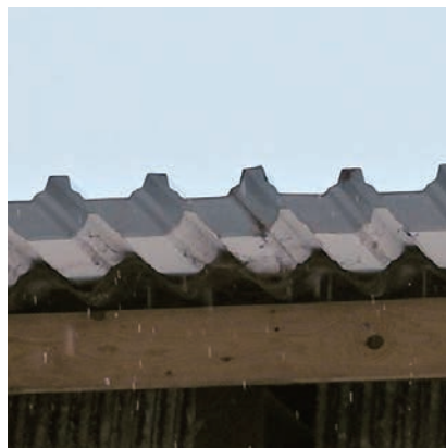
工法②改修後
