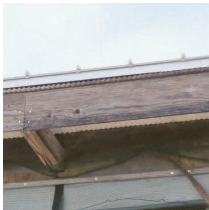
工法③改修後
