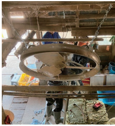
既存の換気扇の移動と角度調整
