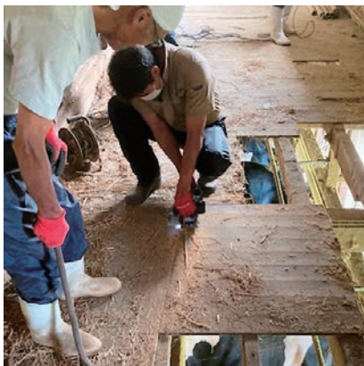
2階部分床板切除
