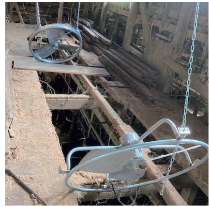
天井から換気扇を吊り下げる様子
