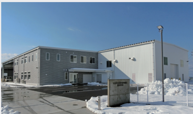
完成した飼料倉庫
